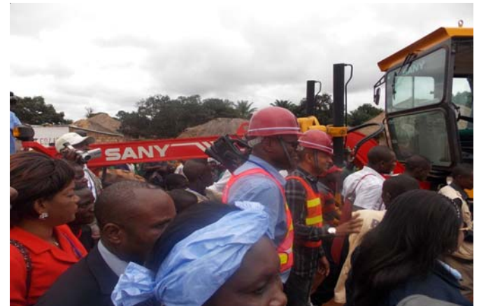
le Directeur des Opérations de la Banque mondiale pour la RD Congo et le Gouverneur du Katanga sur le point de lancer les travaux
