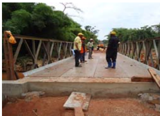
Pont Yeme réhabilité au PK 309
