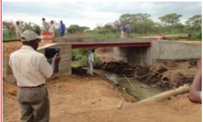
RN 5: un des ponts construits par des PME dans le cadre des Chantiers Pédagogiques
