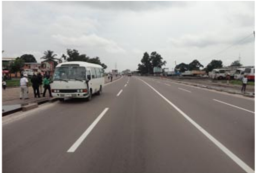
Vue du boulevard Congo-Japon à la fin des travaux
