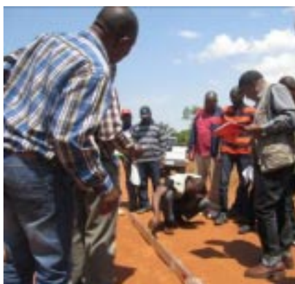
Sur le terrain: Mesure de hauteur de la tôle ondulée sur la route Kasomeno-Kambu
