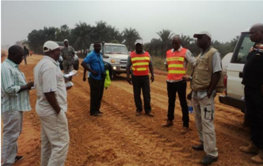
Echanges avec le Chef de Mission Contrôle sur les premiers travaux de la couche de base
