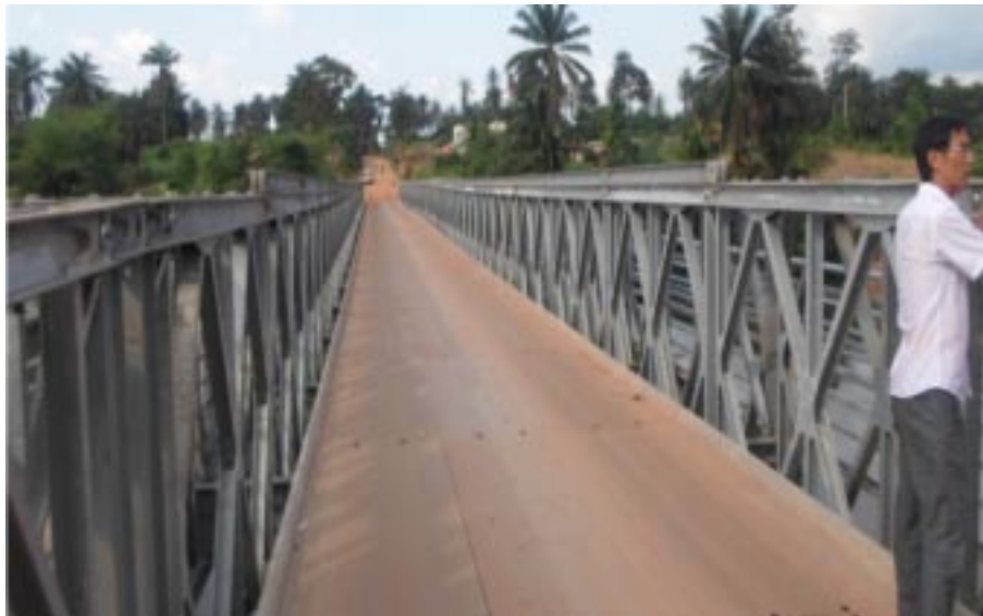
Le nouveau pont de Lindi I.
