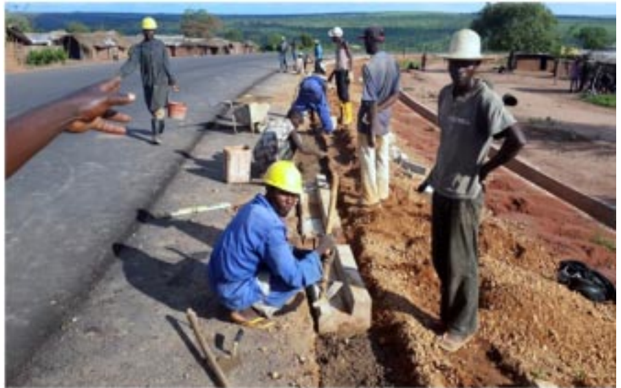
Pose de bordures après la mise en oeuvre du béton bitumineux
