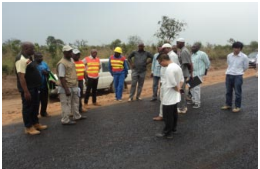
Visite de la première section de la couche d'imprégnation. - 28 août 2015
