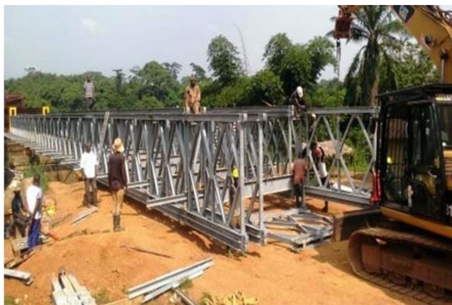
Montage des éléments modulaires du pont Lindi II - décembre 2015
