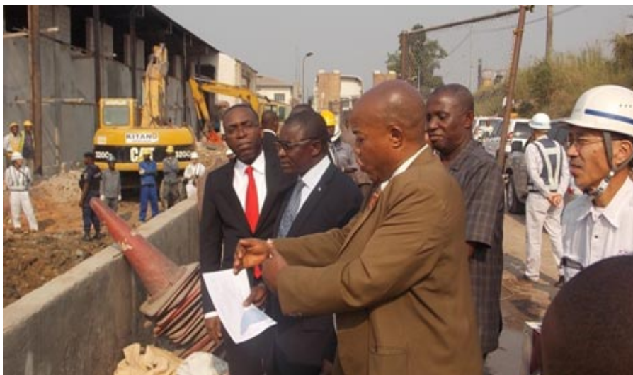
Le Premier Ministre et le Ministre des ITPR suivent les explications du Chef de Section Voiries de la CI, Ir Jean-Pierre Mutamba au niveau du pont Bitshaku-Tshaku
